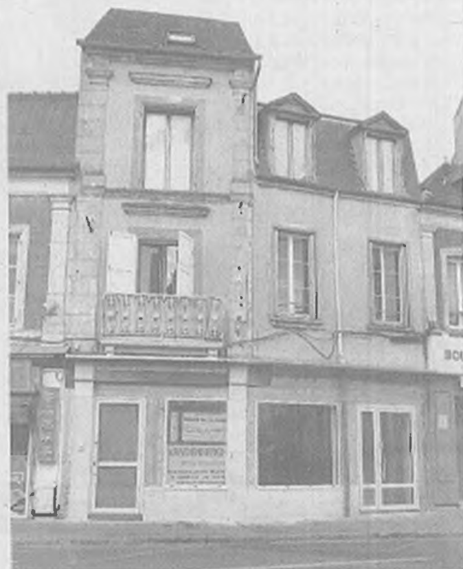
Le rez-de-chaussée du 3 rue de Paris, propriété de la ville de Clermont deviendra le magasin partagé.
